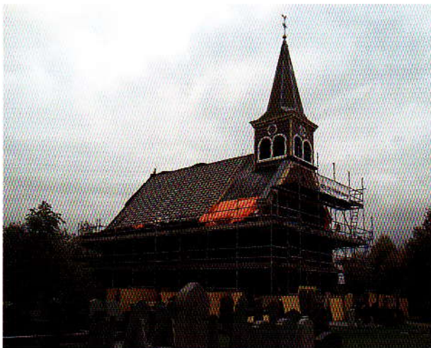
Bij de restauratie van de kerk in Kortezwaag is vooral het dak onder handen genomen.
