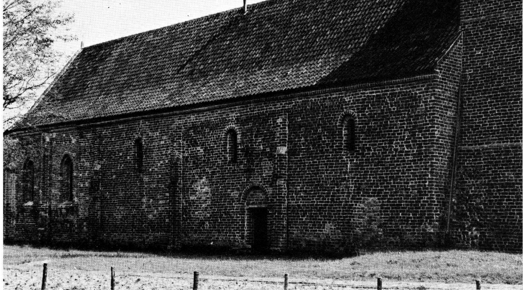
De noordzijde van de kerk te Hoorn. Rechts het romaanse deel uit de 12de eeuw met hoge smalle vensters en een rondbogige ingang; links het later toegevoegde koor.
