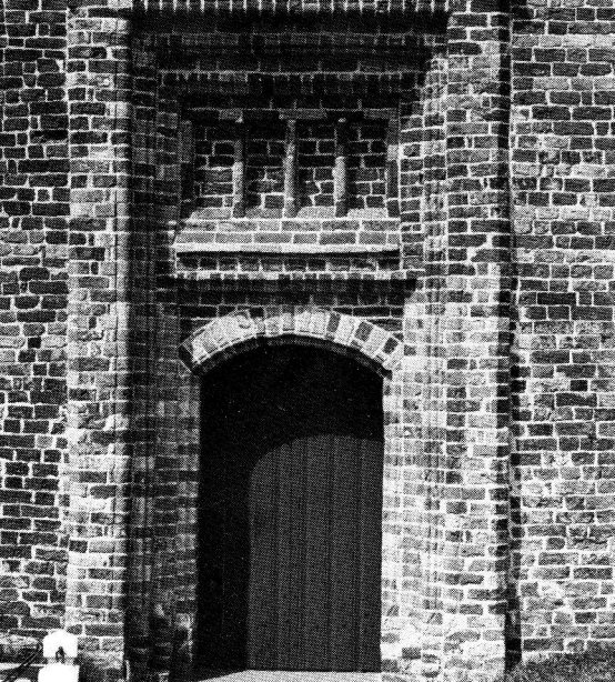
Aan de zuidzijde werd de romaanse ingang in de gotische periode vervangen door deze rijk geprofileerde ingangspartij met vier rechthoekige nissen boven de deur. Een soortgelijke ingang heeft de kerk te Finkum.
