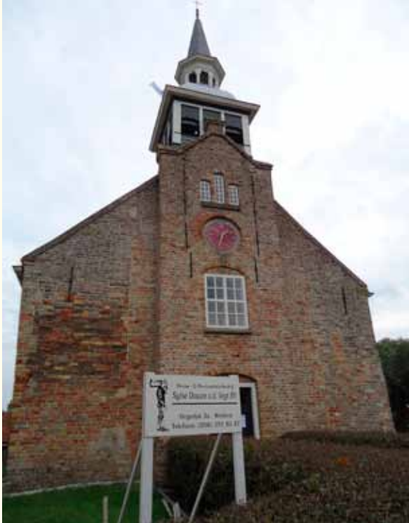
Aan de kerk in Peins is dit najaar onderhoud gepleegd in het kader van de BRIM. Foto Gerhard Bakker
