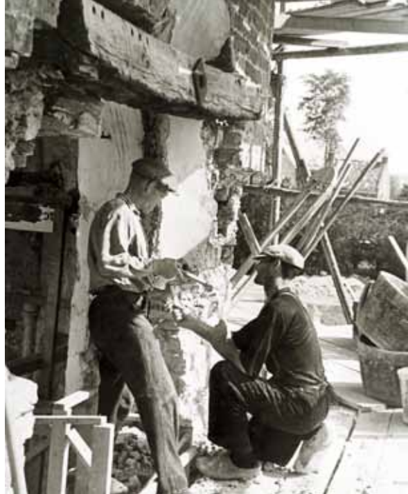
De metselaars op een weinig ARBO verantwoorde manier bezig met het herstel van het koor. Foto Albert Reinstra / Veel van de werklieden die aan de kerk gewerkt hebben lieten hun sporen na in de nieuw gebouwde kapconstructie. Zie noot 4. Foto Collectie RCE
