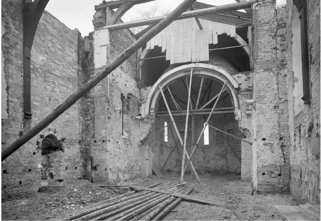
Overzicht van het interieur gedurende de restauratie. De technische toestand laat duidelijk te wensen over. Foto collectie RCE
