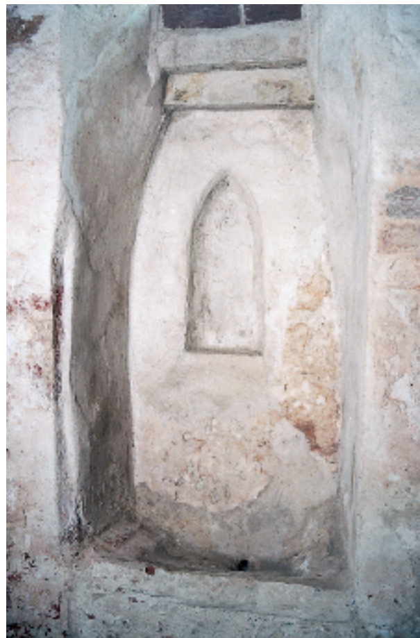
Hoorn, piscina met gedicht venster en bekken van baksteen
