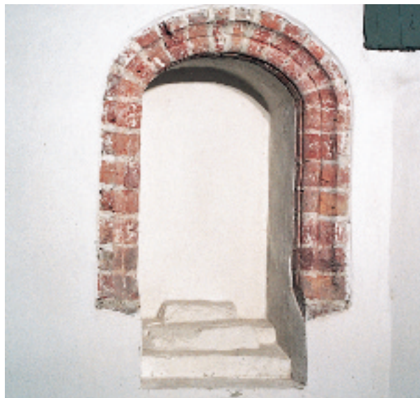
Jouswier, piscina met (beschadigde) getrapte vloer, waarschijnlijk voor de plaatsing van de ampullen
