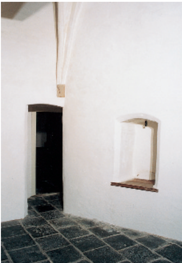
Leeuwarden, Jacobijnerkerk, piscina in de sacristie; links deur naar het koor
