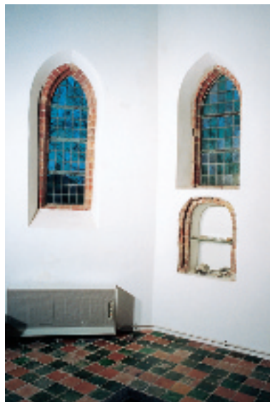
Waaksens, zuidoostzijde van het koor; ter wille van de piscina is bij de bouw een venster ingekort
