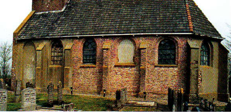
De kerk in 2003 zonder de pleister op een deel van de zuidmuur
