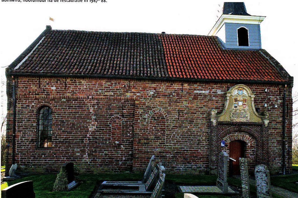
Bornwird, noordmuur na de restauratie in 1987-'88.
