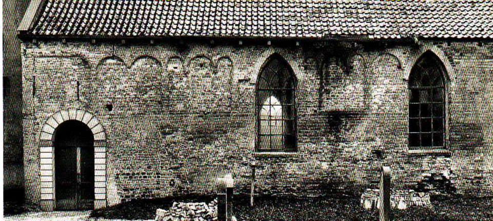
Oldeberkoop, zuidmuur vóór de restauratie in 1927-'30 ; foto Instituut voor Christelijk Cultureel Erfgoed
