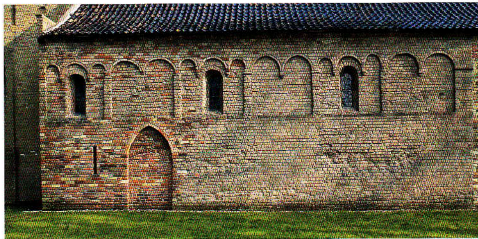
Oldeberkoop, zuidmuur na de restauratie
