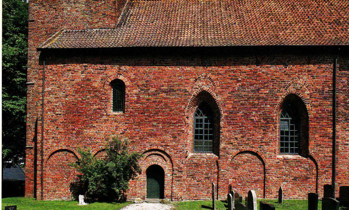
Westergeest, zuidmuur na de restauratie in 1954-'57.
