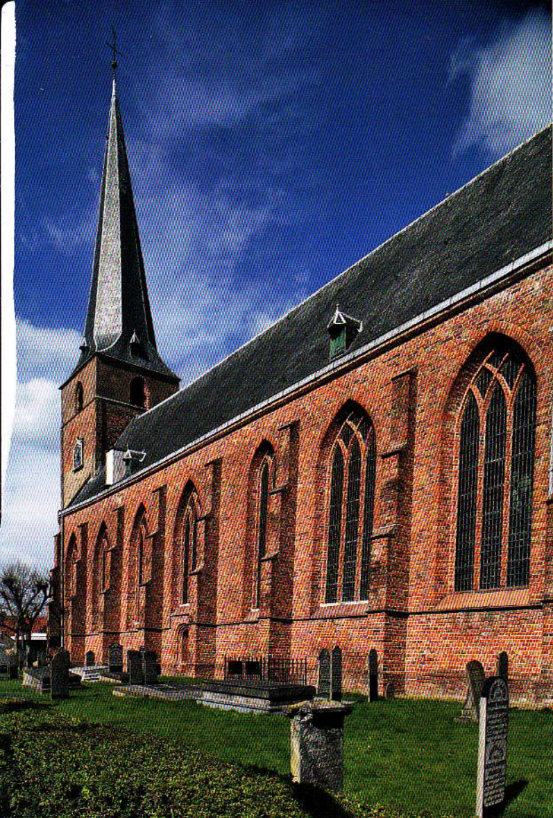
Kollum, zuidmuur na de restauratie in 1962-'69 met herstel van de stenen traceringen in de vensters.
