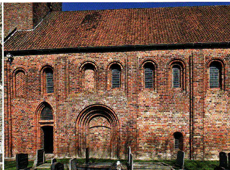
Hantumhuizen, zuidmuur na de restauratie
