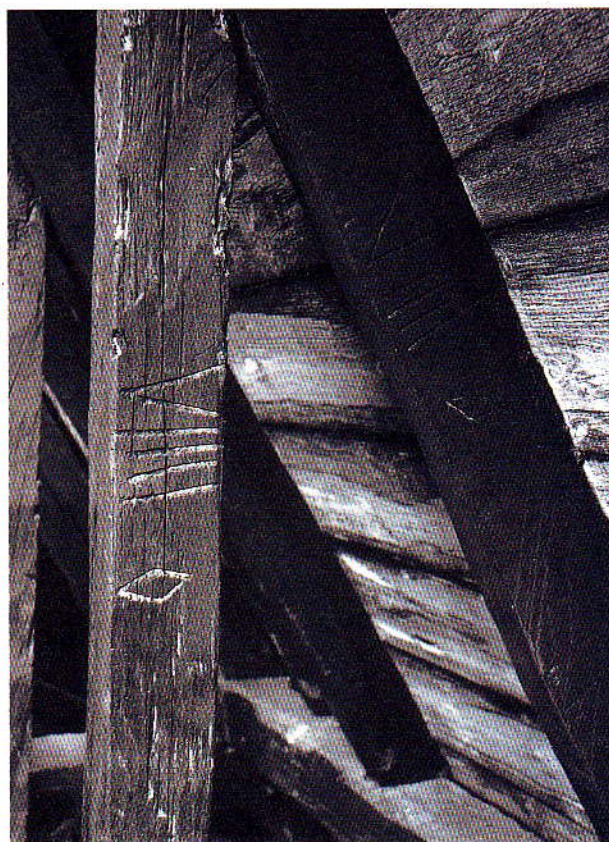
Het gesneden telmerk nummer 9 (V=5) met daarbij het toegevoegde, ruitvormige richtings- teken (afb. 11)
