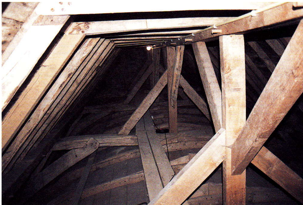
Overzicht sporenkap met standvinken, haanhoutfloring, voet- en windschoren (afb. 8)
