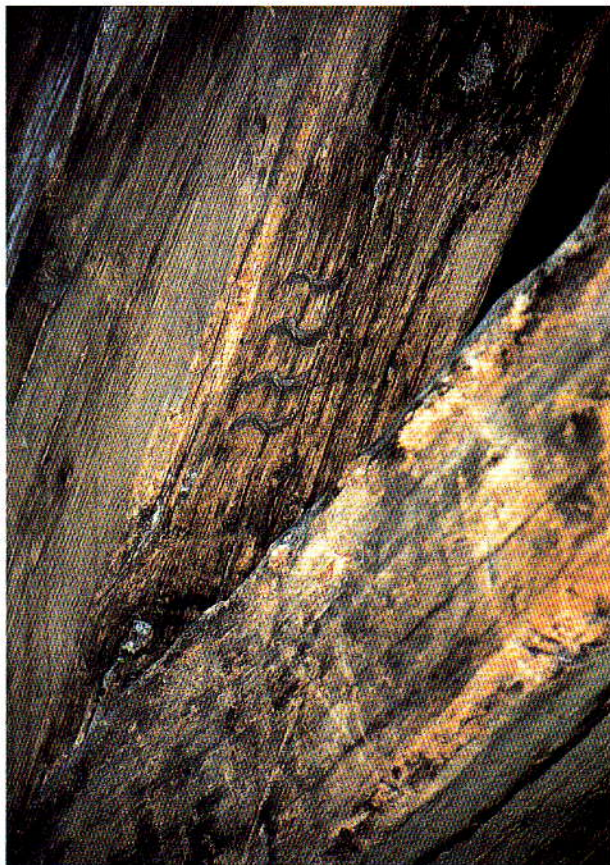
Met een guts gehakt telmerk nummer 4. De S-vormige tekens bestaan uit twee op elkaar geplaatste guisen ( afb. 12 )
