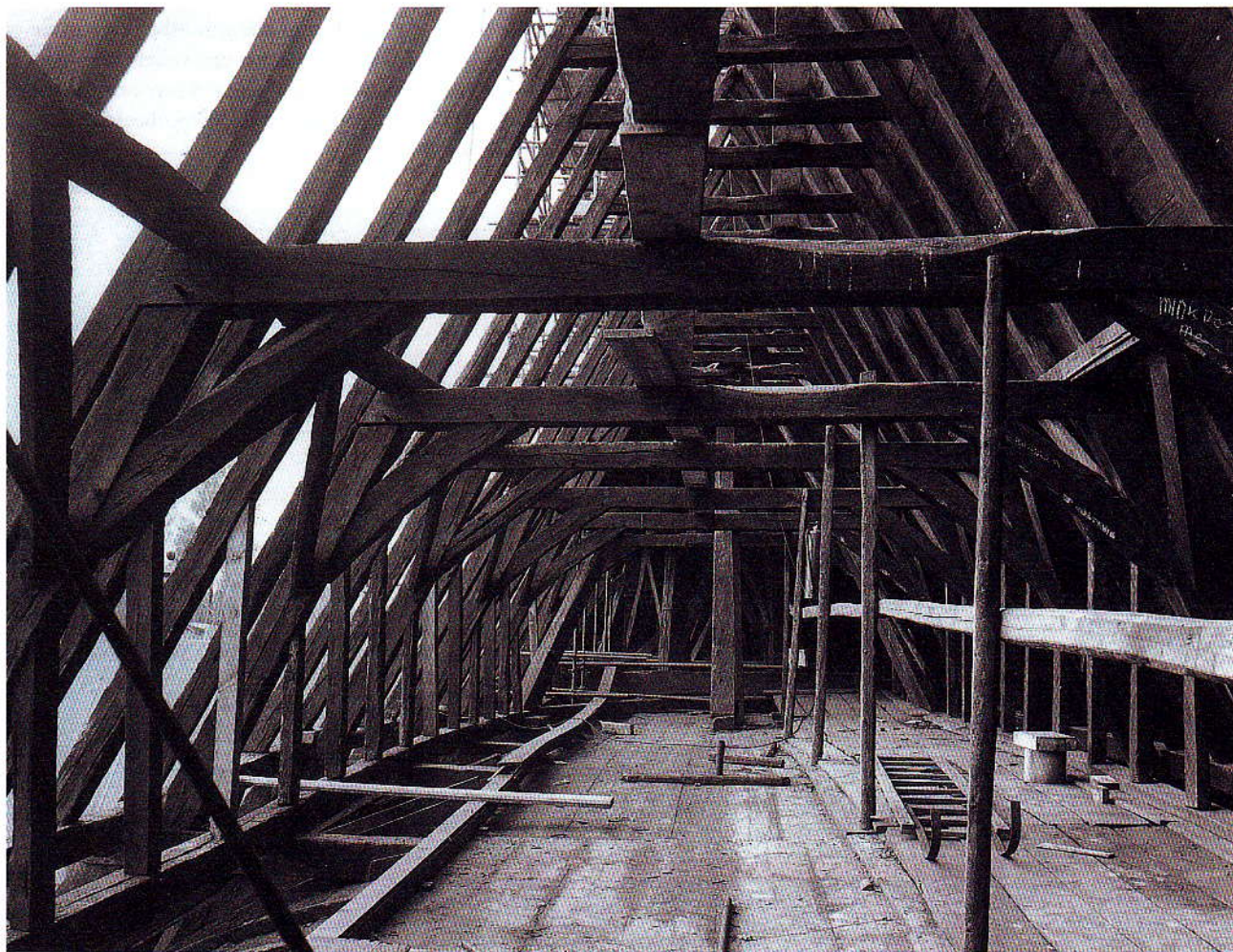
Overzicht van de koorkap met gebinten en sporenparen op de Jacobijnerkerk te Leeuwarden (afb. 8)
