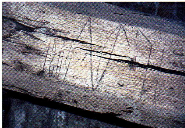
Merk met de Arabische cijfers 1204 en twee onbekende tekens. Dit soort merken komt veel voor op naaldhouten balken en soms, zoals hier in de klokkenstoel te Bozum, ook op eiken (afb. 6)
