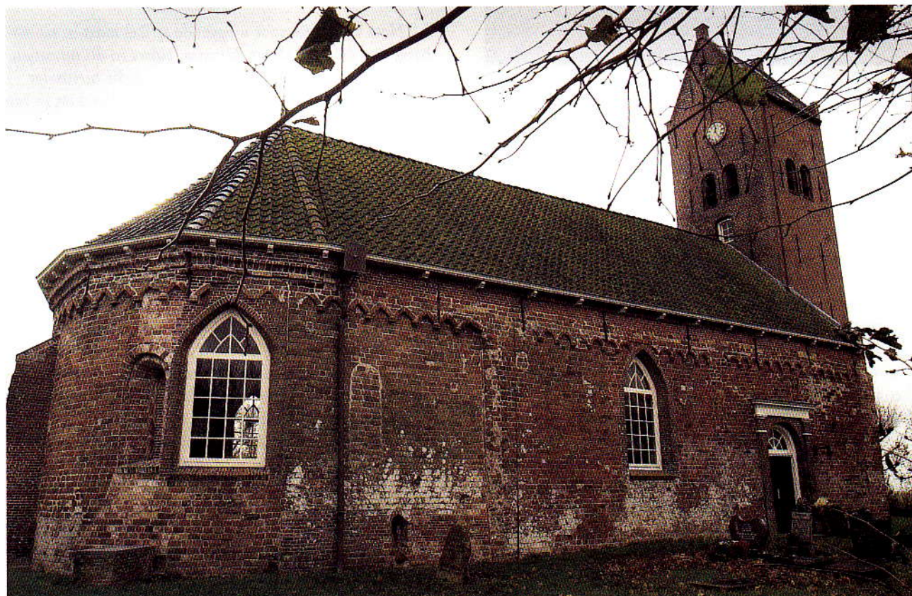
Koor met rondbogenfries, keperbogenfries en sporen van dichtgezet venster. Schip met rondbogenfries en sporen van afgehaakte lisenen. (afb. 1)
