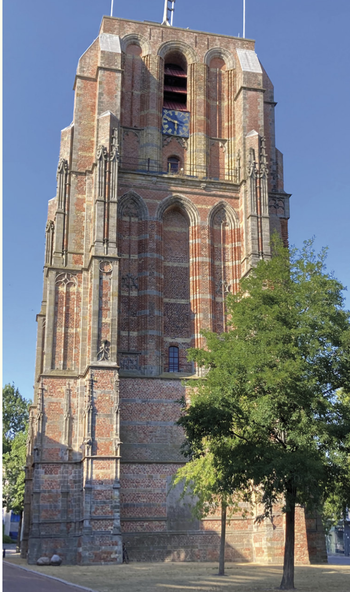
De Oldehovetoren in Leeuwarden, met zicht op de ingemetselde grafzerk (gedeeltelijk verscholen achter de boom) De foto's bij dit artikel zijn van de auteur, tenzij anders vermeld
