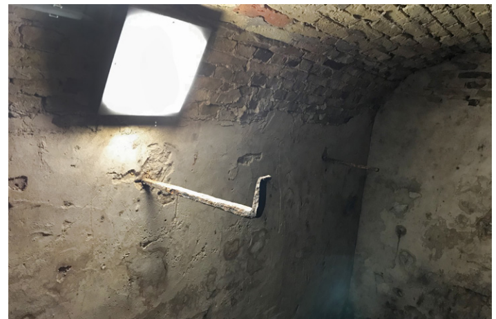
Beugels in de wand van de Aysma-kelder te Schettens.
