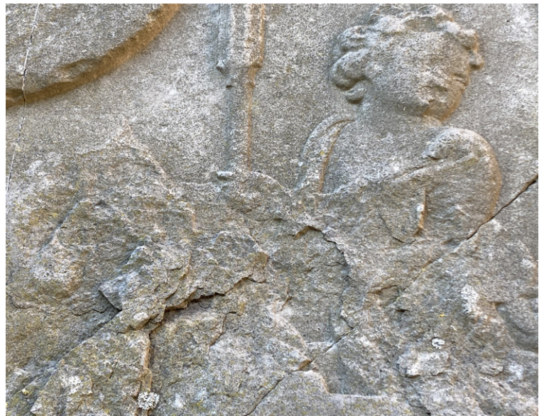
Het afschilferende oppervlak van de grafzerk (linksonder een korstmos) en twee 'steken'
