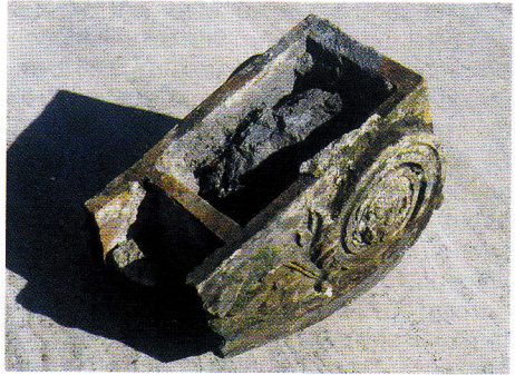
▲ 2) Achterzijde. De holle zijde kon tegen het werk worden bevestigd met specie of door het er tegenaan te schroeven. De ribben dienen ter versteviging van de wanden.
