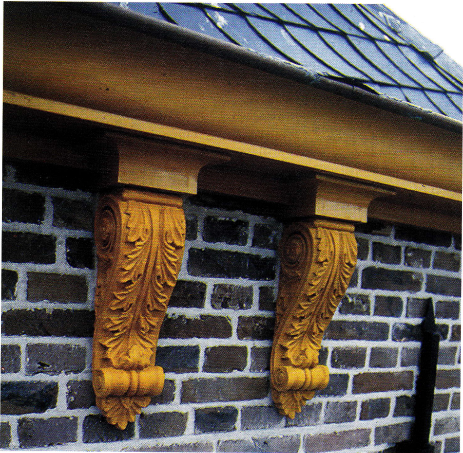
▲ 3) Kunststenen consoles, zoals die thans zijn aangebracht
