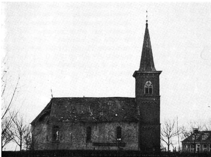
2. Door de storm van november 1972 was het dak van de kerk zwaar beschadigd. Boven het koor was een groot gat en aan de noordzijde waren weinig pannen op hun plaats gebleven. Coll. R.D.M.Z. te Zeist.
