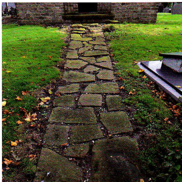
Jorwerd: met brokken sarcofaagdekseel geplaveid pad naar het portaal in de toren
