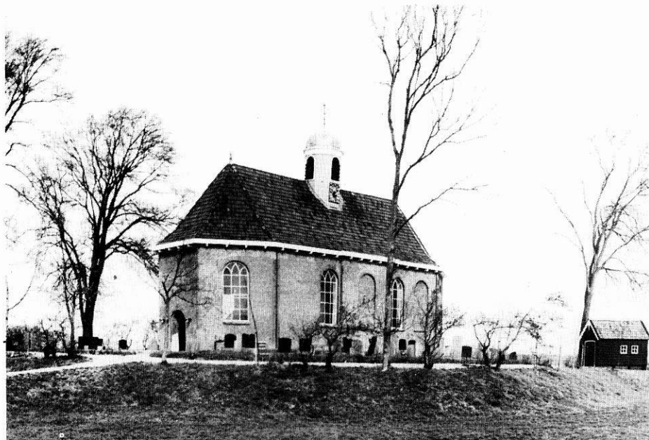
Na de restauratie helt de dakruiter over naar het zuiden.
