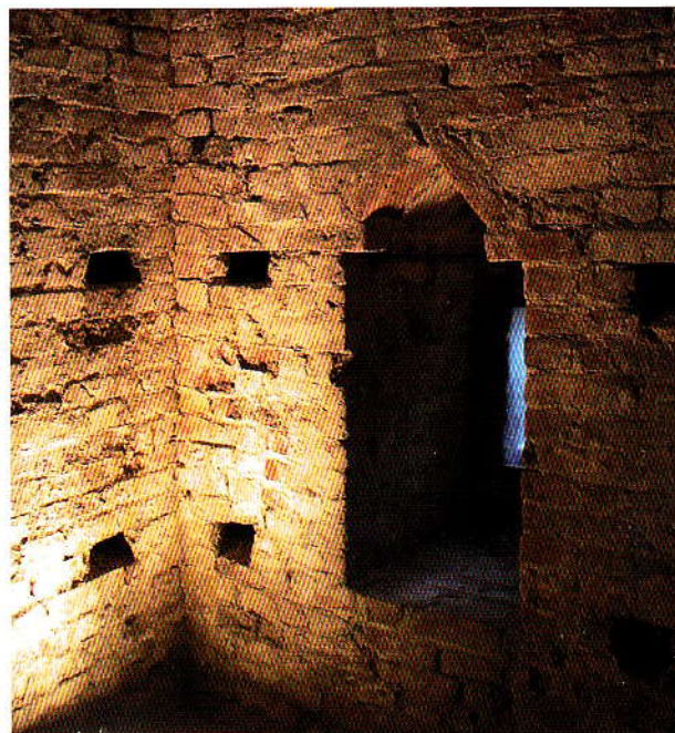
Het verdiepingsvenster in de westgevel van de toren. De donkere kortelinggaten links gaan onder een hoek van 45 graden door het muurwerk
