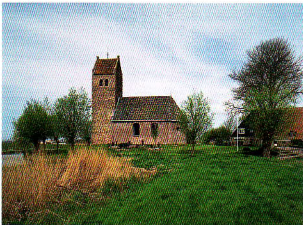
Het exterieur na de restauratie
