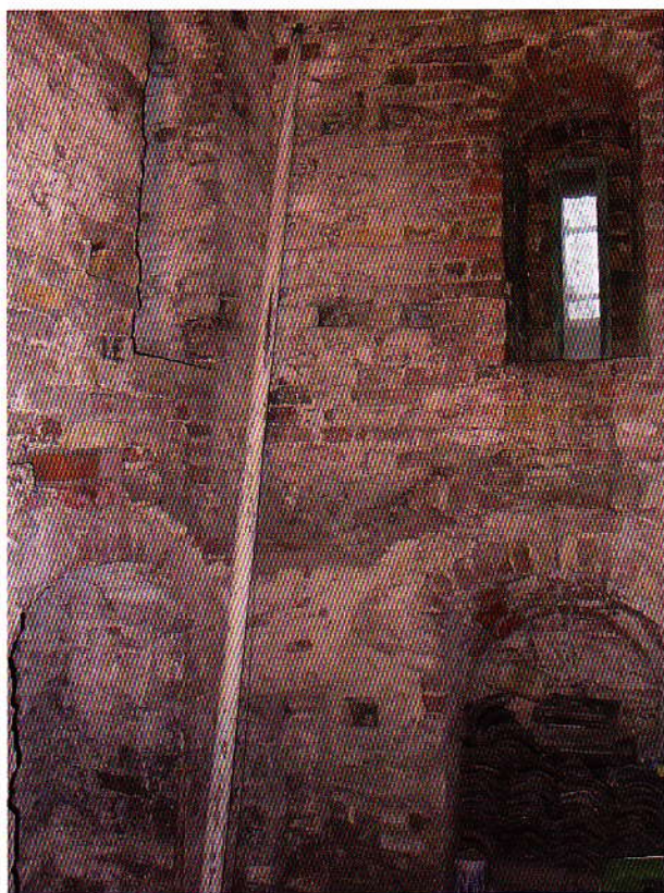
De zuidwesthoek van de toren aan de binnenzijde. Beneden de oorspronkelijke begane grond die van oudsher overwelfd was. Op de verdiepingshoogte de spleetvensters in de west- en zuidmuur
