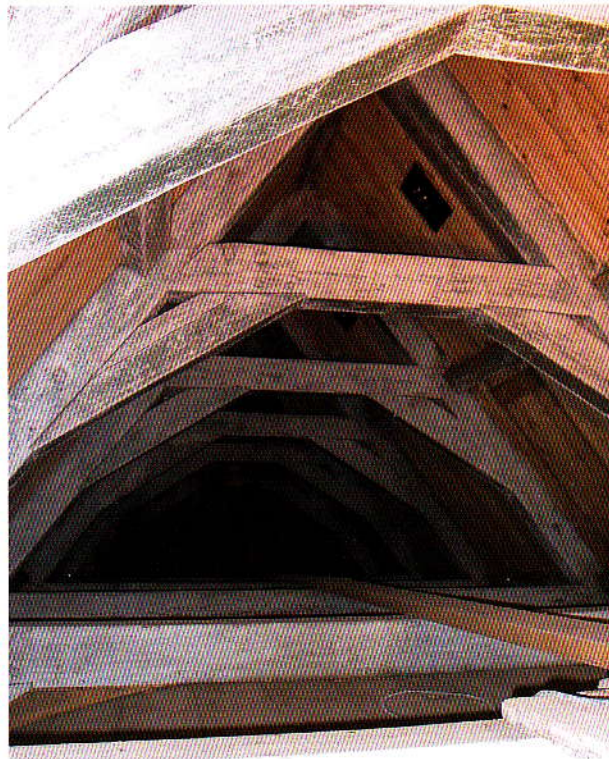
Overzicht van de kapconstructie uit 1708 richting het oosten. De onderdelen die van beneden af zichtbaar waren zijn olijfgroen geschilderd. Ook het dakbeschoot had oorspronkelijk deze kleur
