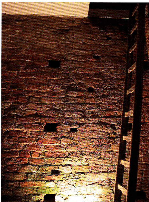
Op de verdieping van de toren zijn een aantal ingehakte kepen zichtbaar die mogelijk te maken hebben met een oudere ladderconstructie. De grote gaten recht boven elkaar zijn de zogenaamde kortelinggaten
