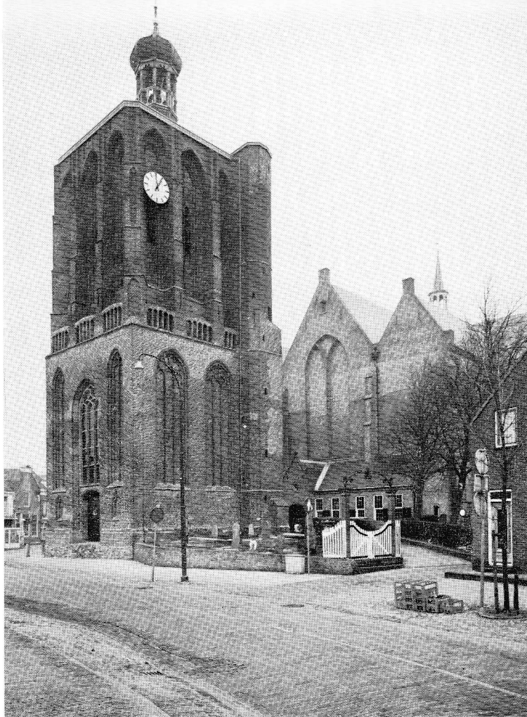
Toren uit het zuidwesten en de westgevel van de kerk. Beide na de restauratie.
