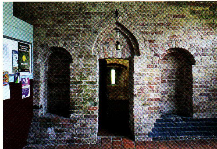
Ureterp, de oostmuur van de toren met zicht in de binnenruimte
