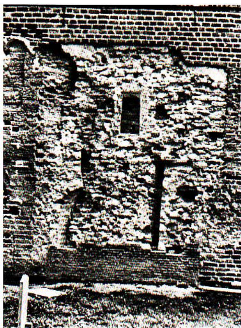
Wetsens, situatie noordzijde bij de restauratie in 1973; links de aanzet van de absis
