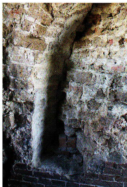
Wetsens, aanzet van de absis in de noordmuur
