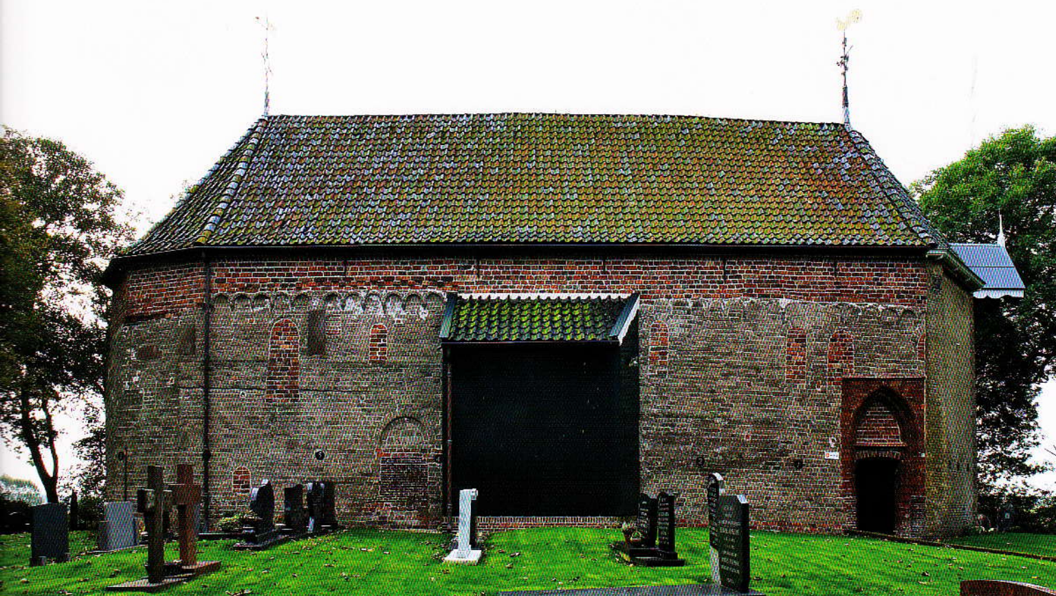
Wetsens, noordzijde met nieuwe houten bescherming van het restant van de absis
