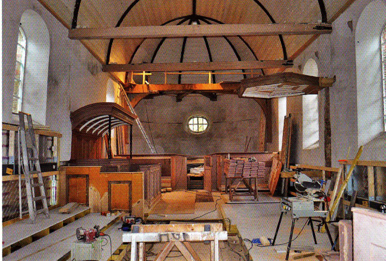
Medio maart konden de werkzaamheden aan de kerk van Wier worden hervat. De restauratie wordt afgerond door aannemer Dijkstra De Graaf BV uit Engwierum. Foto Willem de Graaf
