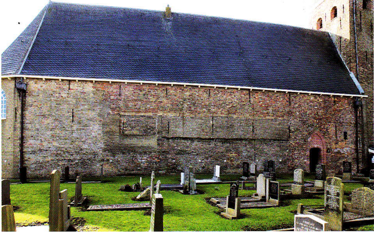
Noordzijde. In het midden de romaanse tufsteenmuur (ca. 1100); links het vroeggotische koor en rechts verlenging tot en met toren (ca. 1250); midden boven verhoging van het schip (ca. 1500)
