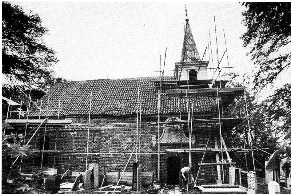
Noordmuur Bornwird met holle en bolle dakpannen.
