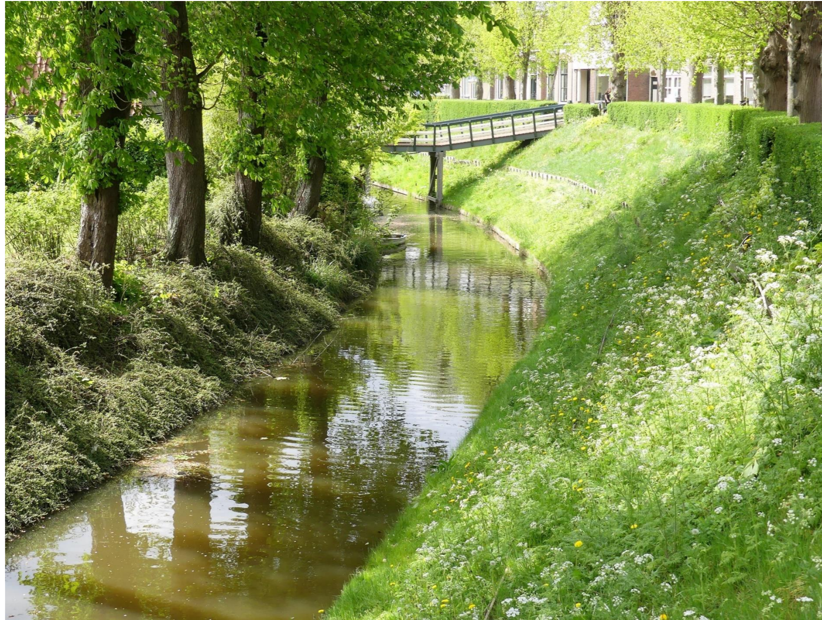
Afb. 6. Ouwe-Dyksterfaart-Zuid, links de Skitelbuurt, rechts steiler talud (50-60 graden)
